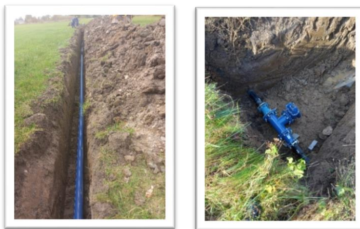
Budowa wodociągu między ul. Warszawską i ul. Nasielską.
