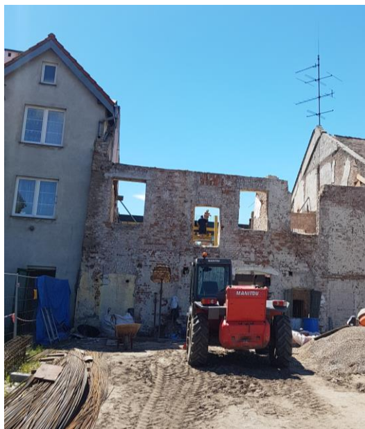
Budynek przy ul. Rynek 13 w trakcie przebudowy
