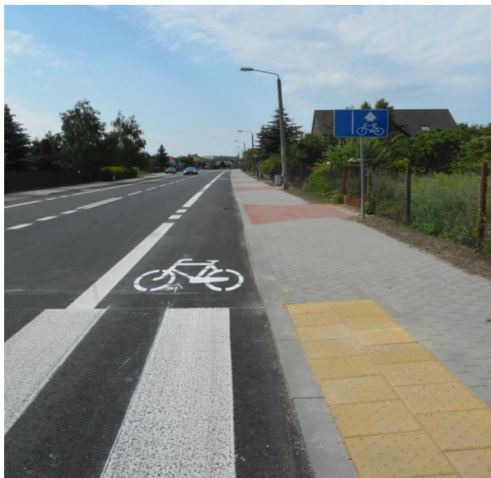
Ul. Wyszyńskiego po przebudowie
