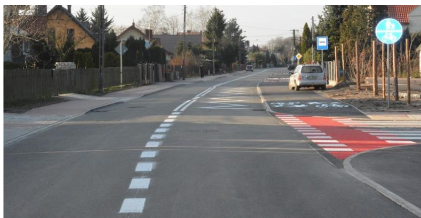
Ul. Bartodziejska po zakończeniu inwestycji
