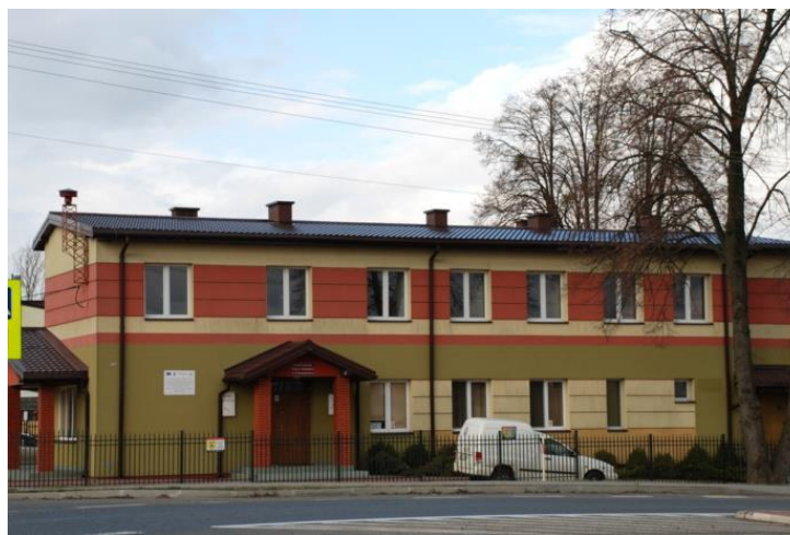
Świetlica w Przemiarowie
