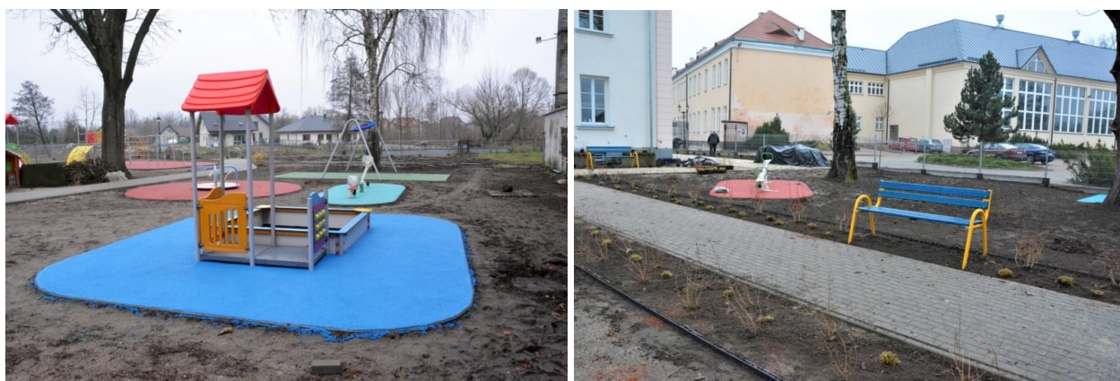
Efekty wykonanych prac
