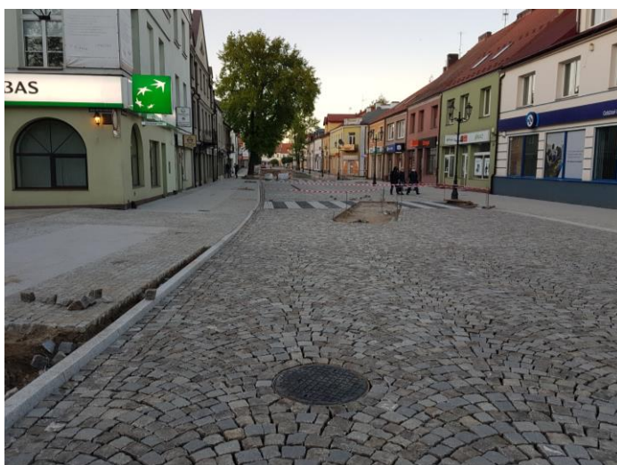
Ul. Świętojańska w trakcie remontu
