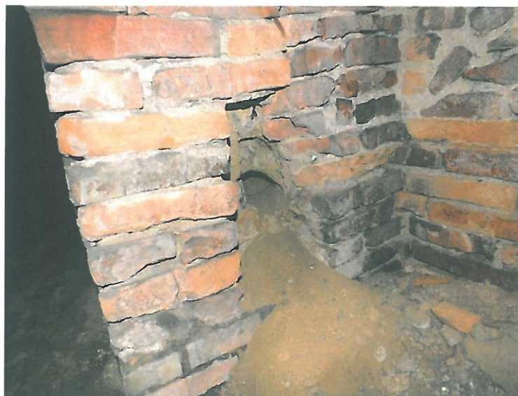
Fot. 5. Detal wykonanych odkrywek w korytarzu A
