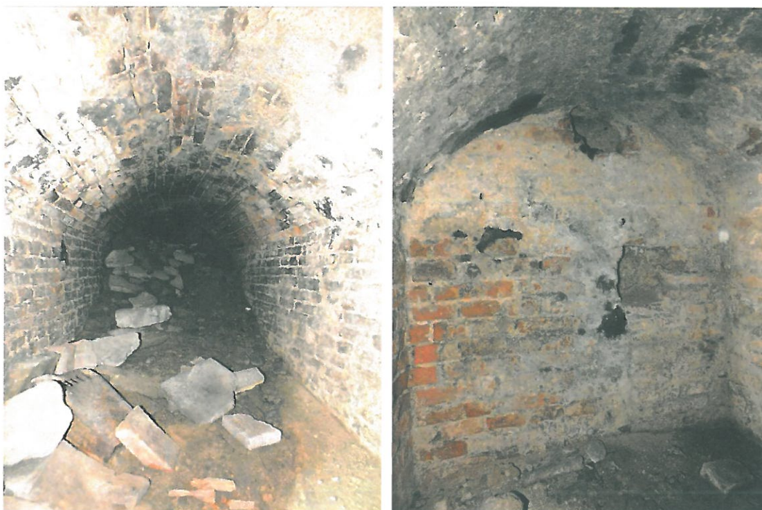
Fot. 6. Widok korytarza B wraz z zasypanym wyjściem. Fot. 7. Zamknięcie korytarza B. Liczne ślady zawilgocenia.
