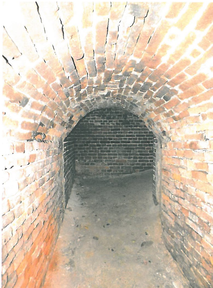
Fot. 8. Widok korytarza C w strefie załamania w korytarz D-E
