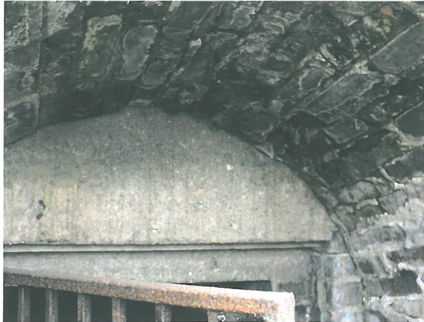
Fot. 3 Detal wtórnie wykonanego nadproża żelbetowego.
