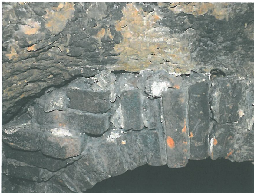
Fot. 13. Detal sklepienia ceglanego (zamknięcie) zabezpieczającego wejście do Sali F.
