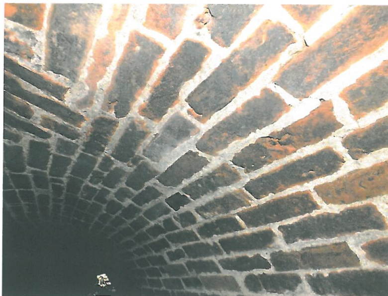
Fot. 11. Dobry stan zachowania substancji murowej oraz zaprawy.
