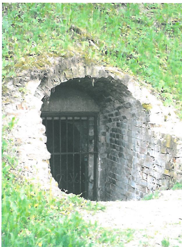
Fot. 2. Widok wejścia do piwnic.
